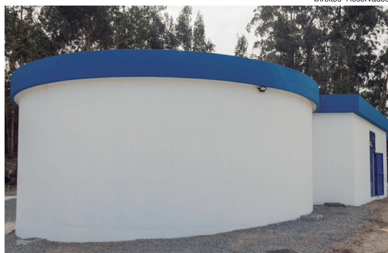
Reservatório está em fase final de construção
